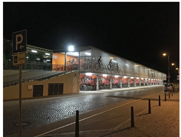
Gut beleuchtetes Fahrradparkhaus
