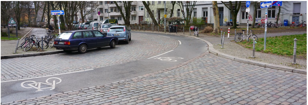
Asphaltstreifen für den Radverkehr
