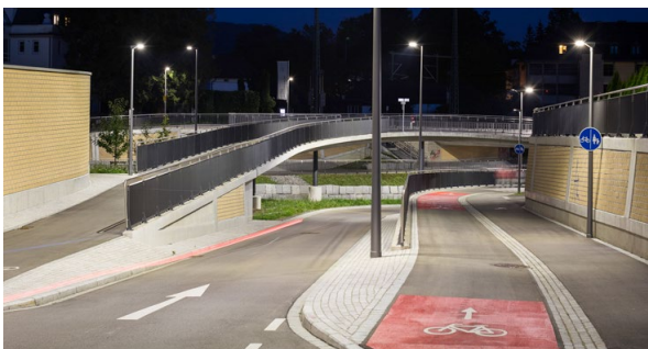
Unterführungen mit einer offenen Bauweise und attraktiver Radverkehrsführung
