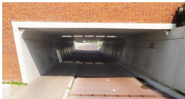
Unterführung mit klarer Streckenführung und guter Einsehbarkeit
