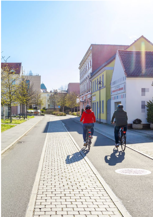
Fahrradstraße mit mittigem Pflasterstreifen zur optischen Einengung der Fahrbahn
