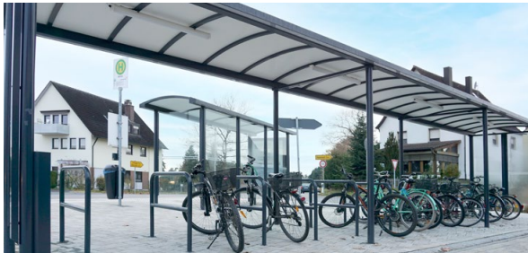
Überdachte und beleuchtete Radabstellanlage an einer Bushaltestelle im ländlichen Raum
